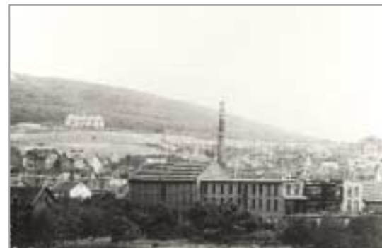
Lederfabrik auf dem heutigen Parkplatz am Untertor 1928
